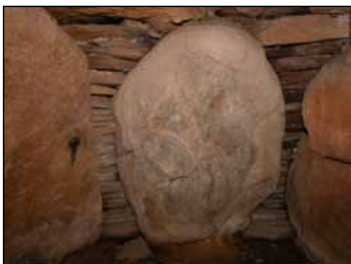
Den smukke tørmur mellem de tonstunge bæresten er tætnet med birkebark, ler og knust flint.
